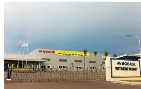
Nhà máy MOBASE KCN Yên Phong - Bắc Ninh 5/2009
