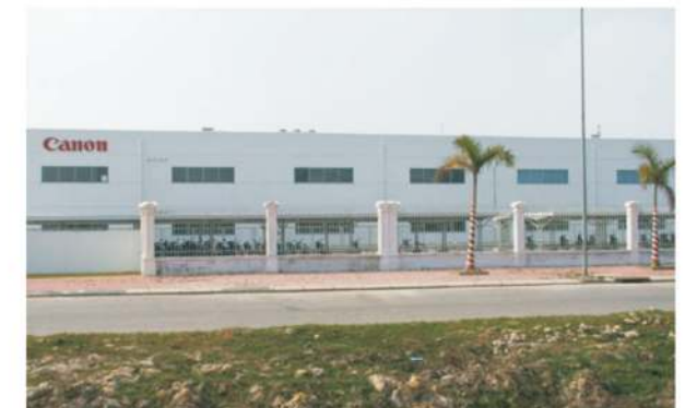
Nhà máy CANON KCN Quế Võ - Bắc Ninh 8/2009
