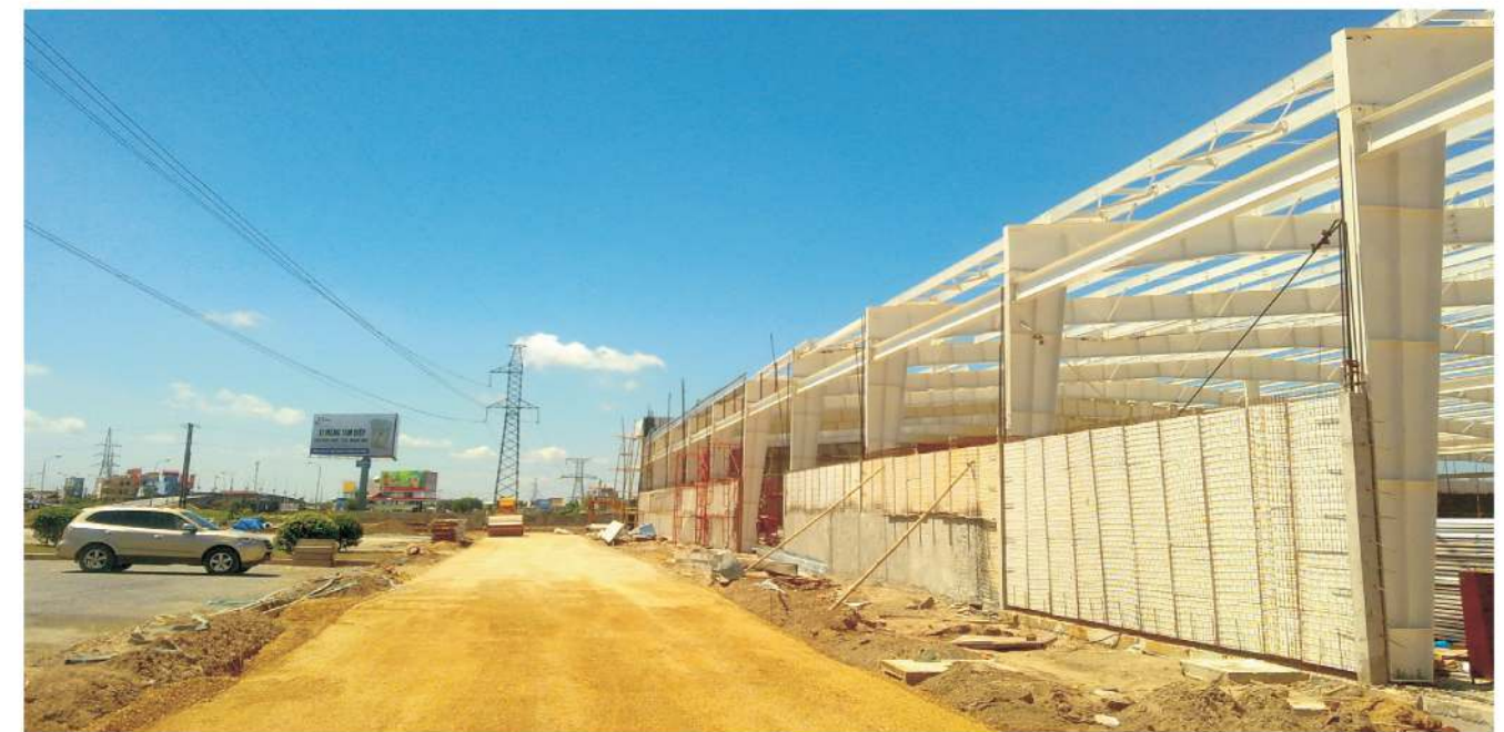
Tường bao che nhà máy sản xuất linh kiện điện tử tập đoàn SAMSUNG
