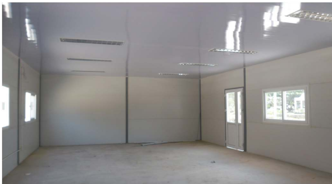
Công trình dự án Tuyến đường Long Vân, Long Mỹ - TP.Quy Nhơn - T.Bình Định
