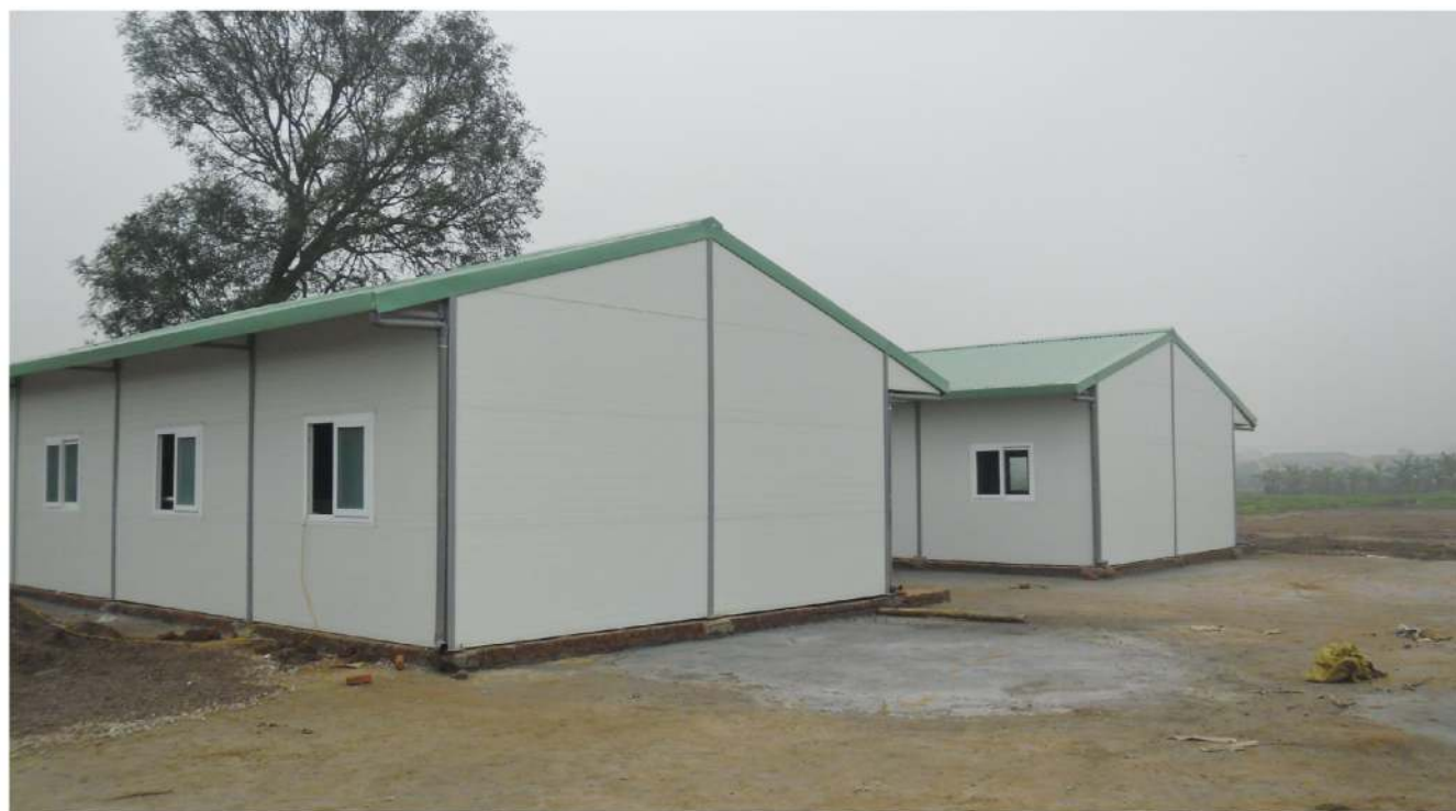
Công trình dự án EX1B cao tốc Hà Nội, Hải Phòng Tổng công ty xây dựng công trình giao thông 1 - Cienco 1
