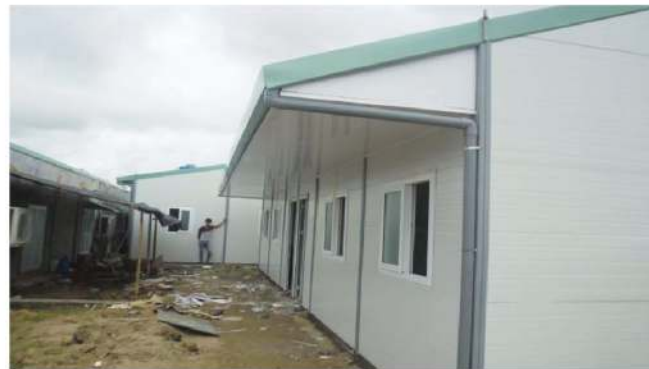
Công trình đường bao - Hải An - Hải Phòng
