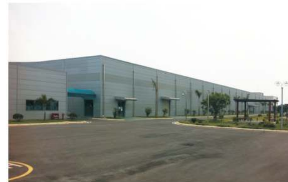
Nhà máy SEONG JY VINA KCN Khai Sơn - Thuận Thành - BN 1/2009
