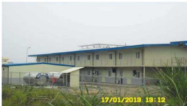
Công trình Mông Dương - Quảng Ninh
