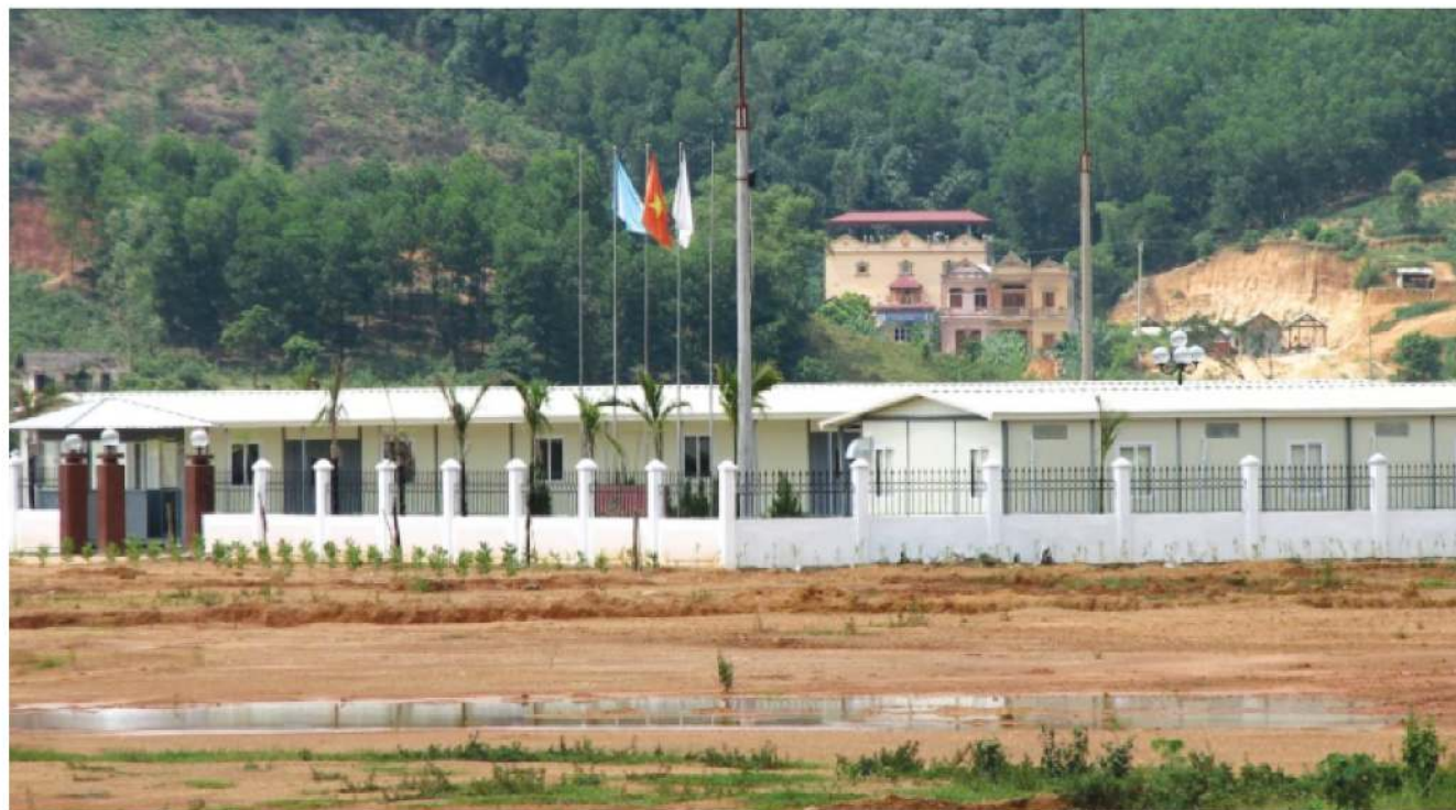
Công trình dự án nâng cấp sân bay Cát Bi – Hải Phòng
